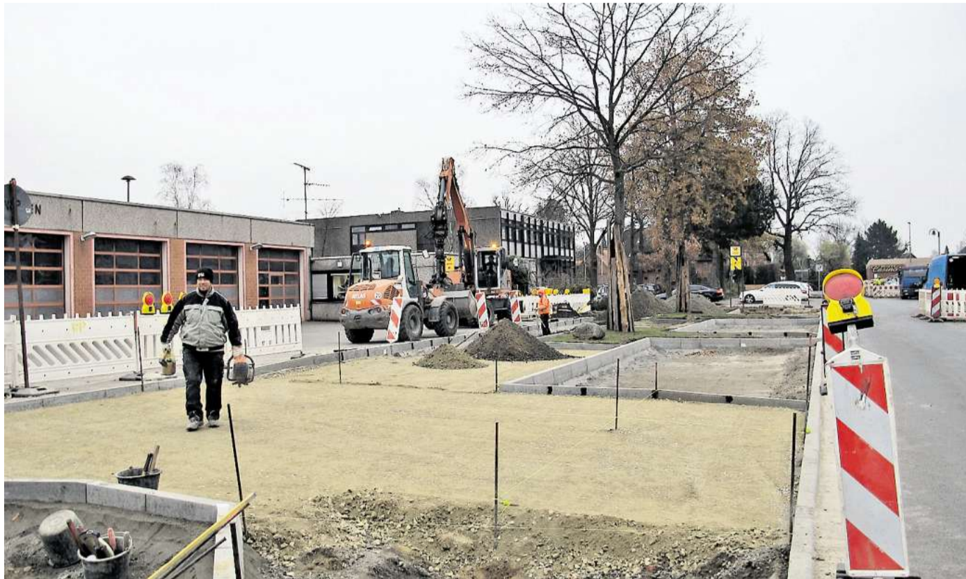
Die Umgestaltung des Rathausumfeldes hat begonnen. Derzeit werden neue Parkboxen vor dem Feuerwehrgerätehaus geschaffen. Am Montag beginnen die Arbeiten auf dem Rathausparkplatz, dann ist mit deutlichen Einschränkungen zu rechnen.
