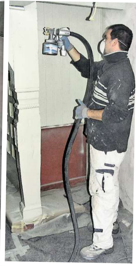
Szenen von der Innen-Sanierung der Kirche in Wipshausen: Der Restaurator arbeitet am Altar (oben), der Maler spritzt neue Farbe auf die Stütze (rechts).
