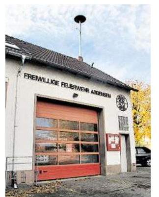
Das alte Feuerwehrgerätehaus in Abbensen. A
