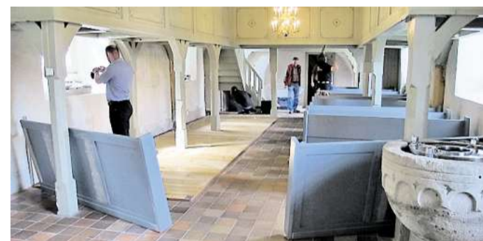
In Wipshausen wird seit etwa zwei Monaten die Kirche renoviert. A
